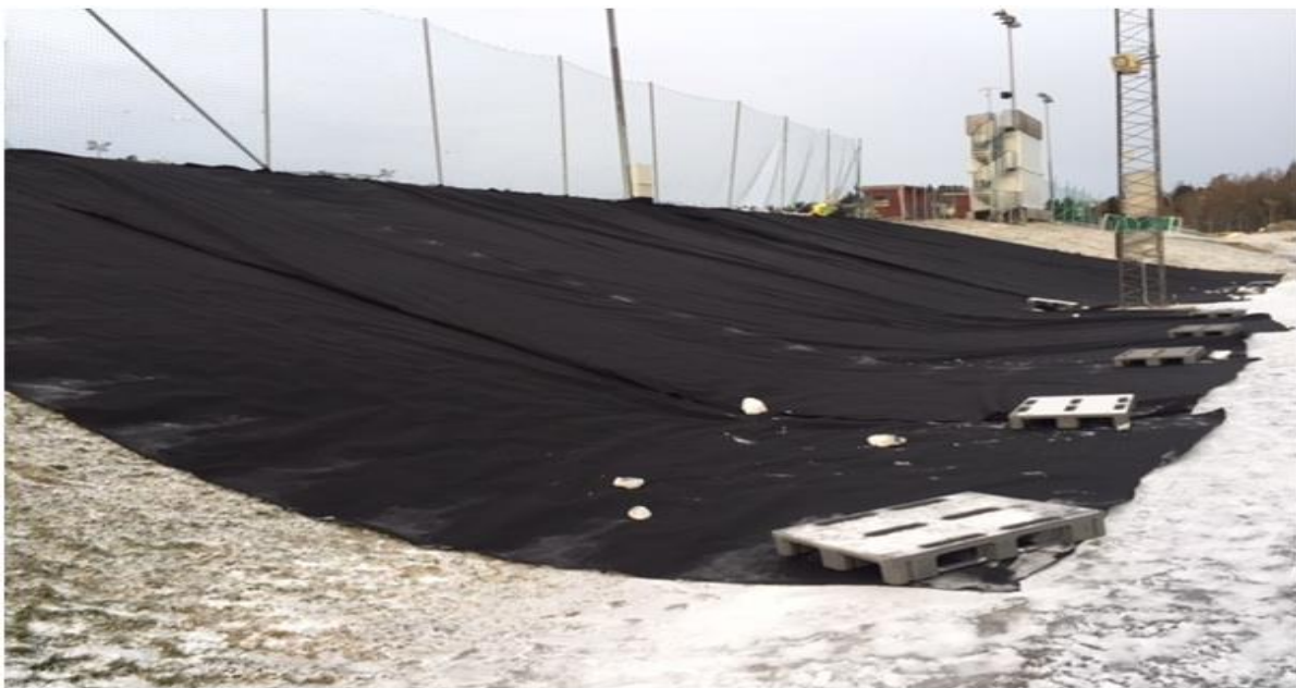
Bilde 1.5.3 Fiberduk som er lagt på nedsiden av Byåsen Arena, senhøsten 2017
