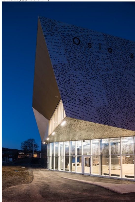
Frontoppslag/hovedinngang, kveldstid. (foto: Finn Ståle Felberg/Kultur- og idrettsbygg Oslo KF)
