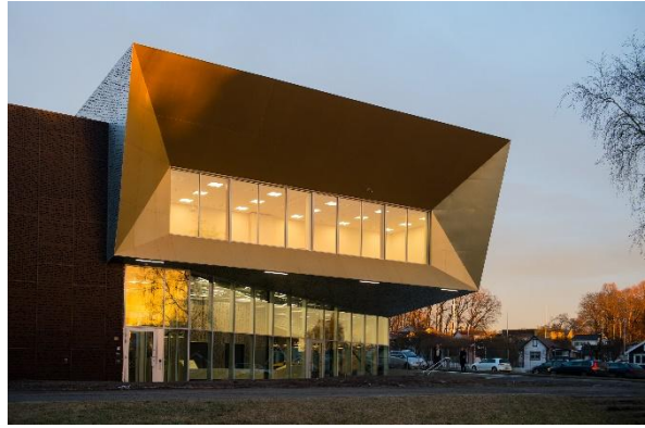
Frontoppslag/hovedinngang, skumring. (foto: Finn Ståle Felberg/Kultur- og idrettsbygg Oslo KF)
