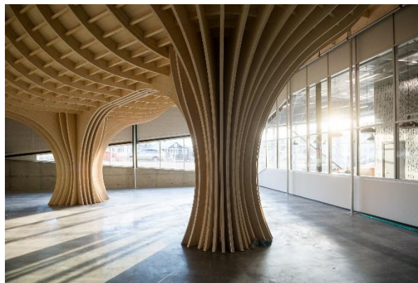
Underside bowl mot Stavangergata og cafe. (foto: Finn Ståle Felberg/Kultur- og idrettsbygg Oslo KF)
