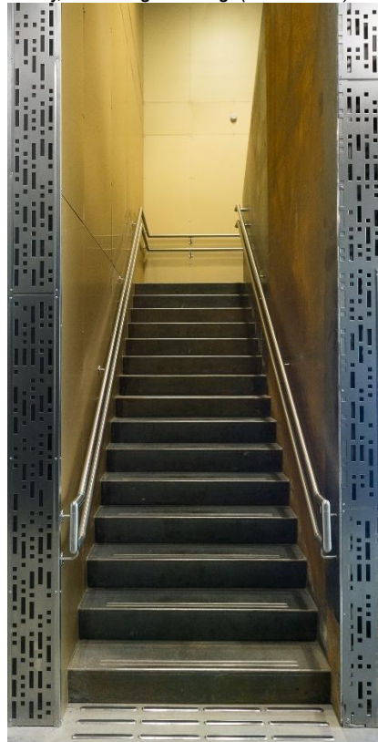
Hovedtrapp. (foto: Finn Ståle Felberg/Kultur- og idrettsbygg Oslo KF)
