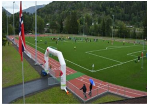
Eksempel på snødeponi på løpebane for friidrett.
