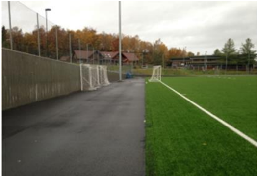
Eksempel på snødeponi på bred asfaltflate.
