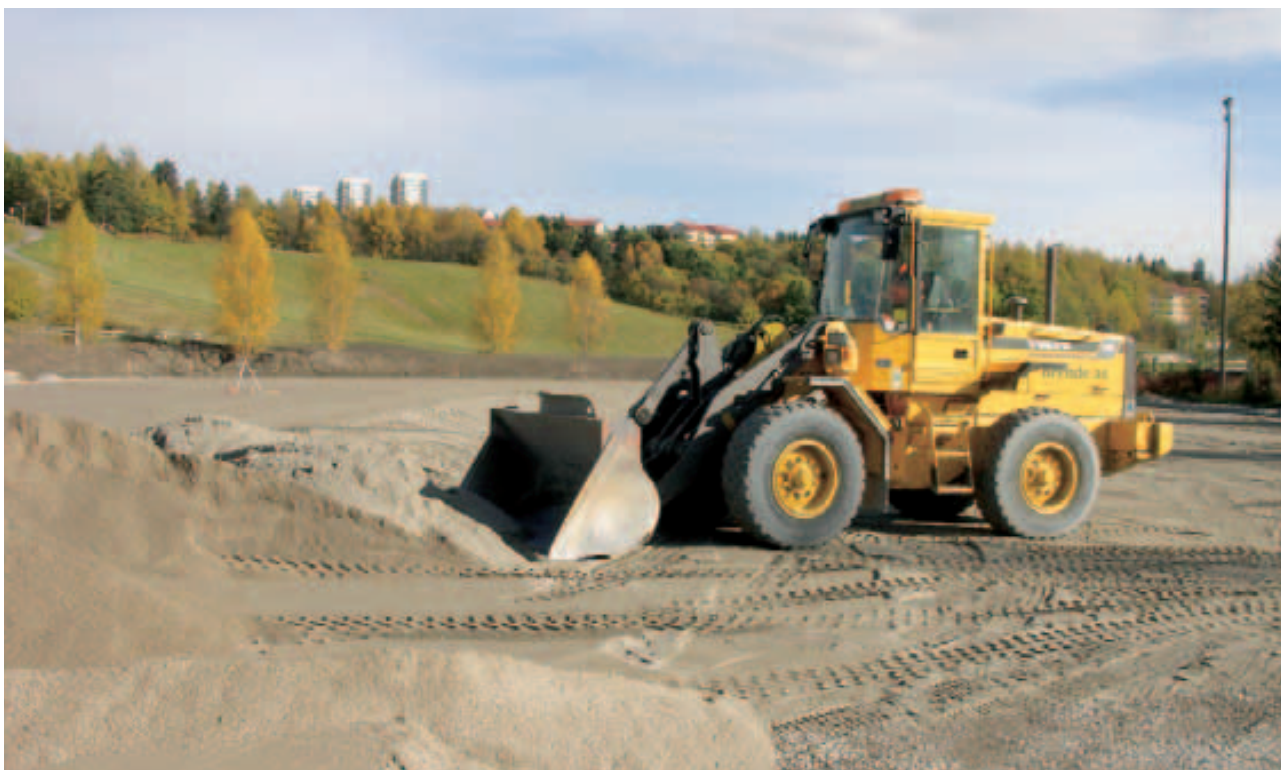
Grovutlegging av toppdekke
