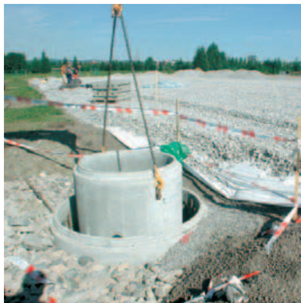
Mastefundament av kumringer.
