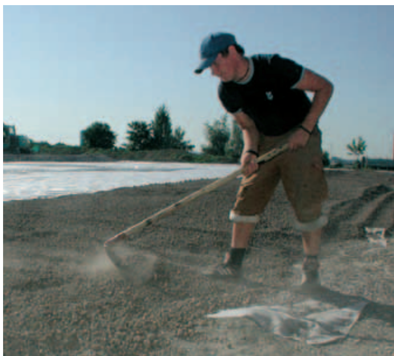
Utlegging av løs lettklinker som drenerende og isolerende lag.
